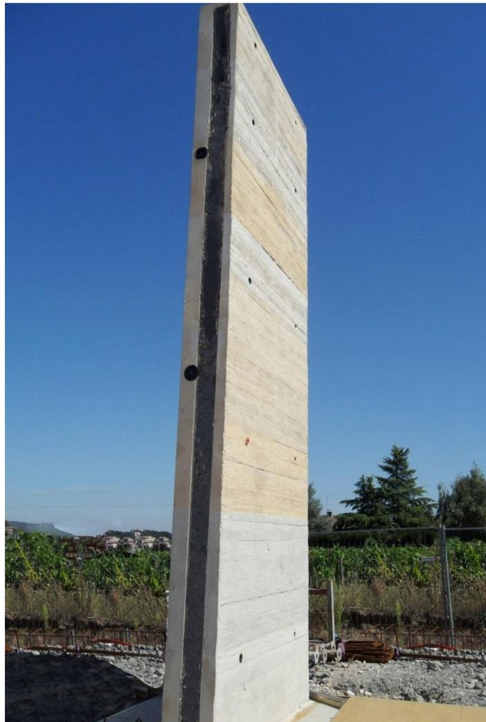
Le procédé GBE® permet également la réalisation de murs courbes coulés en place, ainsi que des murs matricés et colorés.
